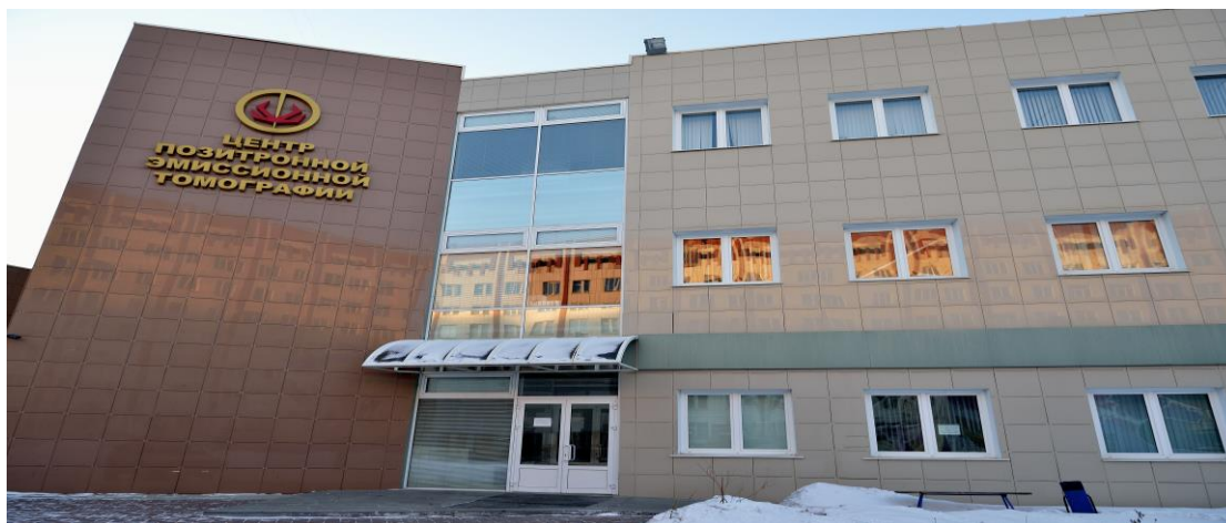
Рис. 33- ПЭТ центр ГБУЗ «ЧОКОД»
